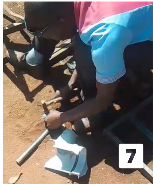
Foto's 6 en 7: Onderhoud van en reparatie aan dakgoten.
